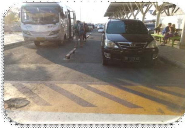
Gambar 1. Fasilitas Jalan Penghubung.
