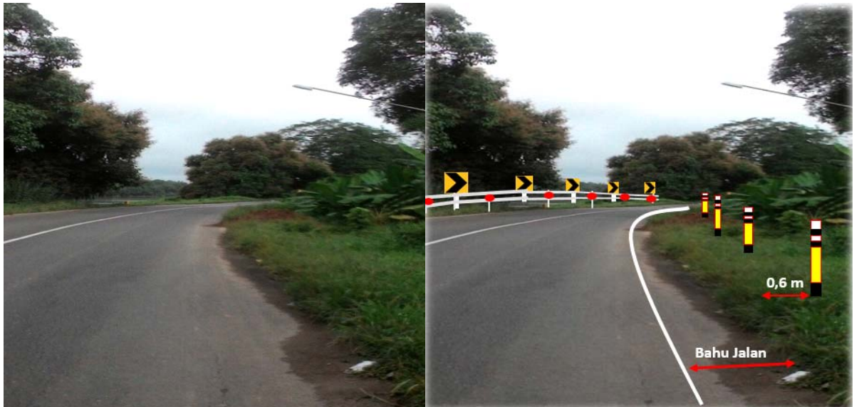
Gambar 8. Penanganan Ruas Jalan Merdeka.
