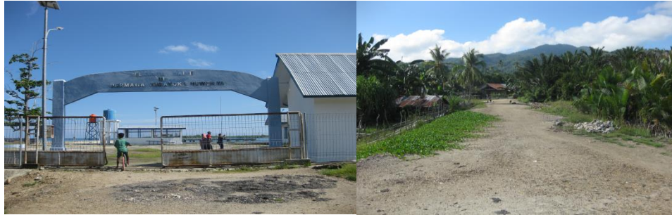
Gambar 6. Kondisi Jaringan Jalan Akses dari dan ke Pelabuhan Manipa
