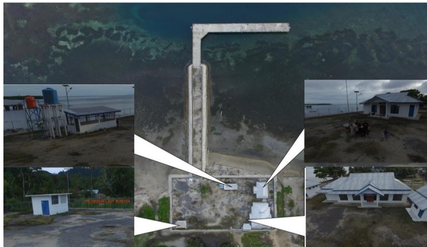
Gambar 7. Fasilitas eksisting Pelabuhan Manipa
