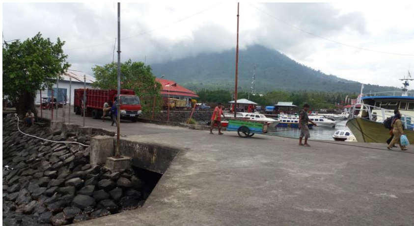
Gambar 1. Kondisi Pelabuhan Jailolo
