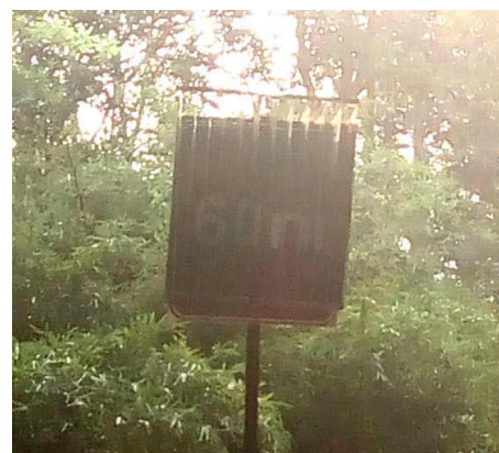
Gambar 8. Rambu Jarak 60 m yang Dipasangi Aling Optik Terlihat Angka 60 m pada Posisi Paling Jelas karena Sudut Lembaran-lembaran Aling Optik Mengarah ke Mata.
