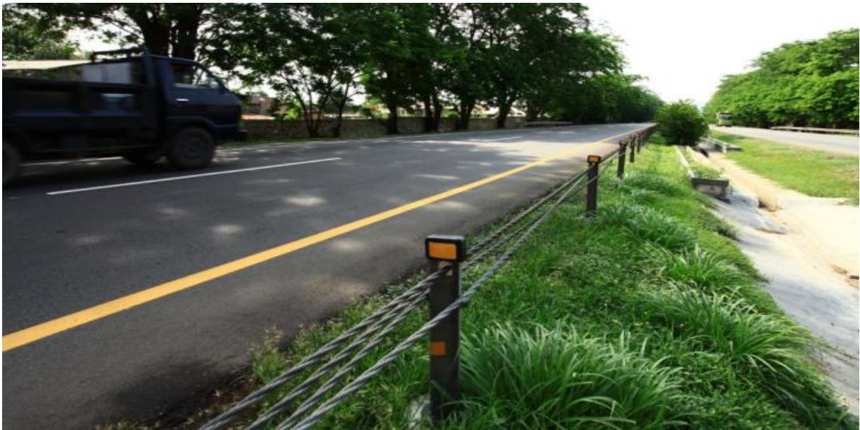
Gambar 2. Wire Rope Terpasang di Ruas Tol Jakarta-Merak.
