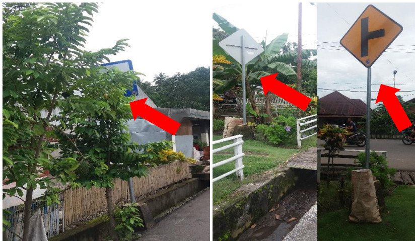
Gambar 14. Kondisi Rambu yang Tertutup Obyek dan Pemasangan Rambu yang Salah di Ruas Jalan Siliwangi Kota Kotamobagu
