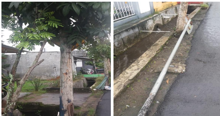
Gambar 10. Kondisi Rambu yang Tertutup Objek dan Patah di Ruas Jalan Veteran Kota Kotamobagu
