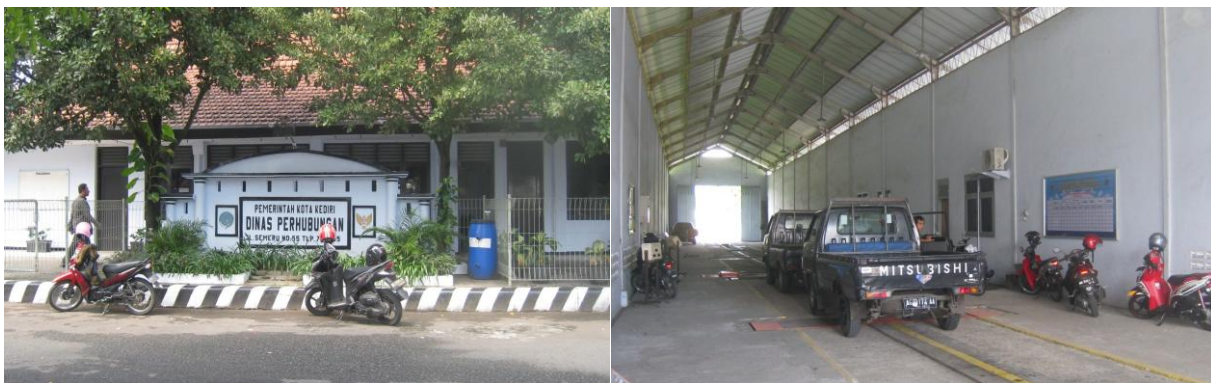
Gambar 3. Kantor Dinas Perhubungan Kota Kediri dan Gedung Pengujian Kendaraan Bermotor
