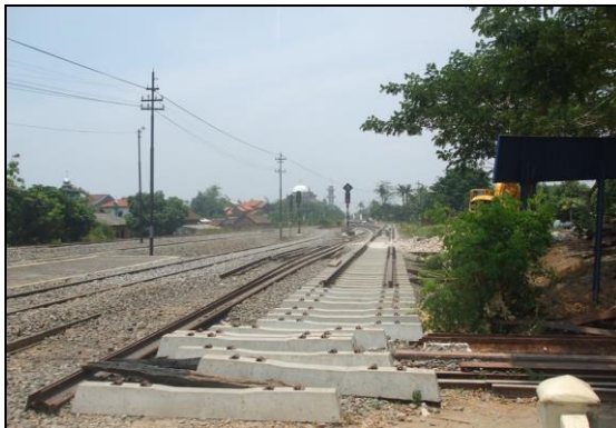
Gambar 4. Pembangunan Double Track
