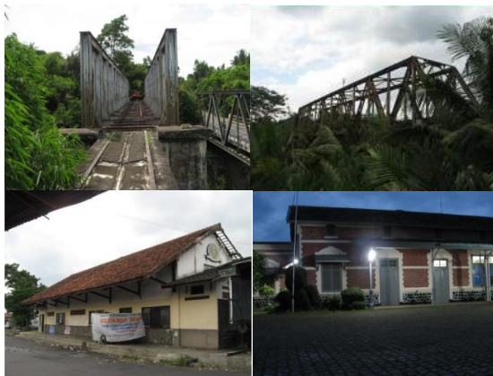
Gambar 5. Jembatan dan Stasiun Kereta Api yang Tidak Beroperasi
