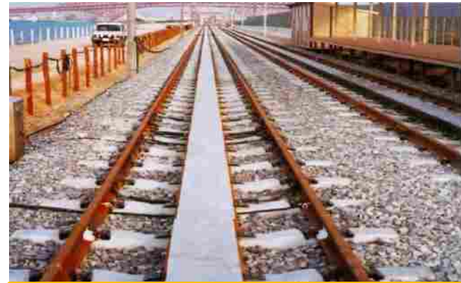
STATOR DIANTARA DUA REL ROTOR DIGANTUNG PADA BOGIE
