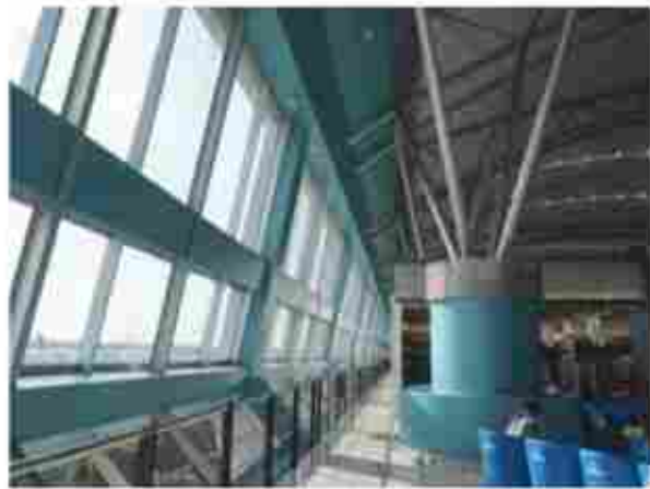
Pemanfaatan cahaya matahari untuk penerangan terminal
