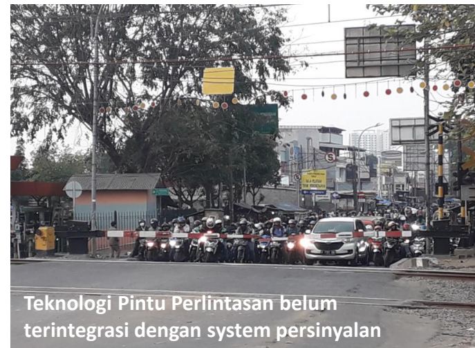
Kondisi perpotongan jalan tidak sesuai ketentuan
